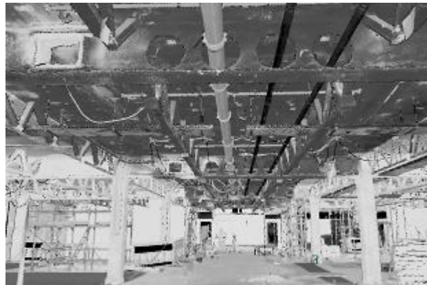
Abb. 2: Erfassung von Unterzügen (inkl. Durchbrüche)
